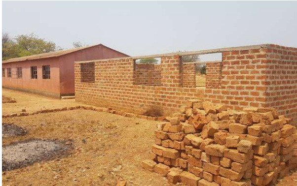
Figuur 14 In aanbouw 2019
